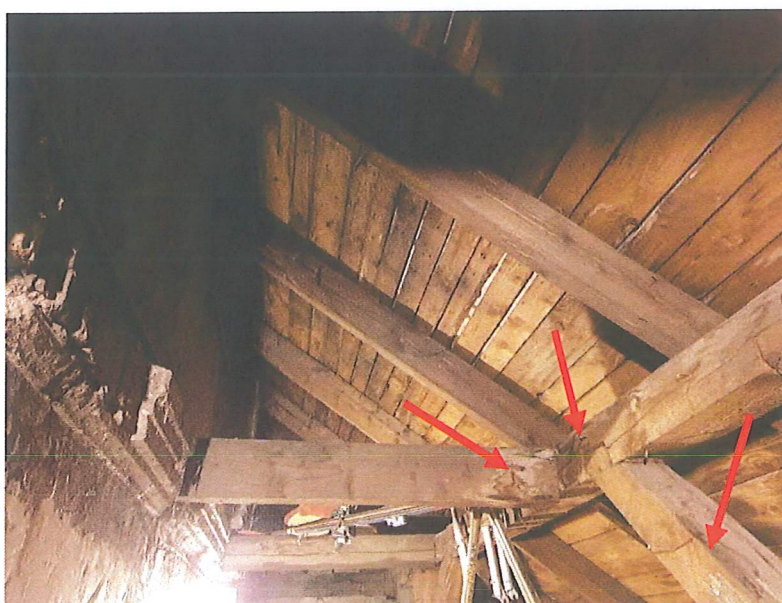
Fot. 21 Widok konstrukcji dachu pulpitowego przybudówki [zacieki na elementach konstrukcyjnych]
