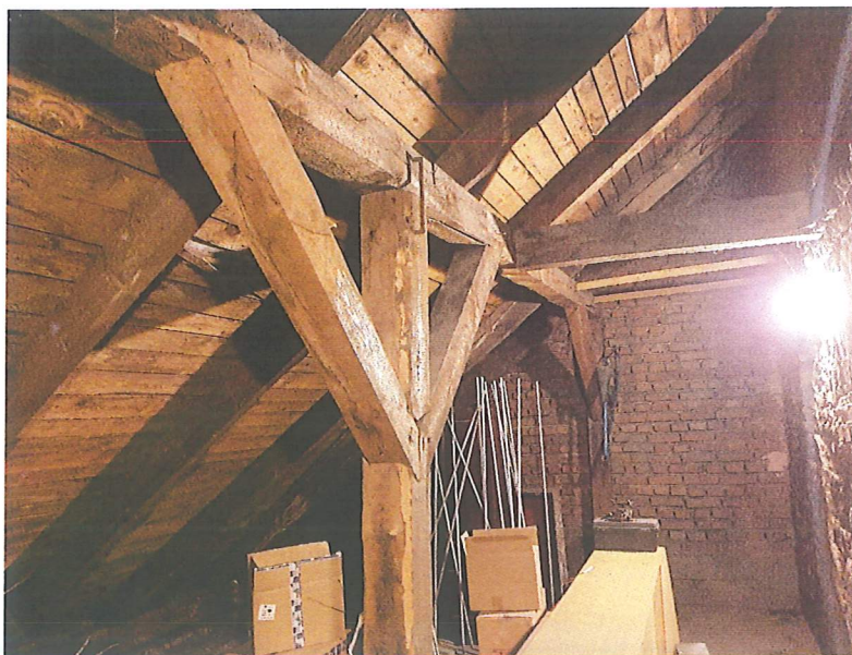
Fot. 19 Widok konstrukcji dachu pulpitowego przybudówki
