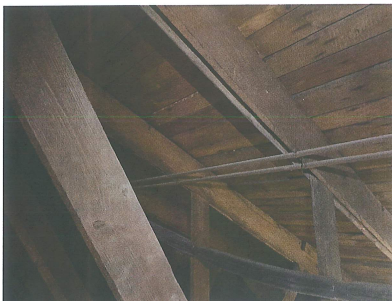
Fot. 11 Widok konstrukcji dachu głównego - deskowy wiązar kratowy
