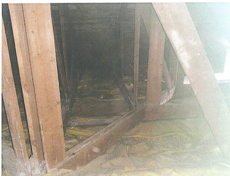
Fot. 15 Widok konstrukcji dachu głównego - deskowy wiązar kratowy [kratownica narożna]
