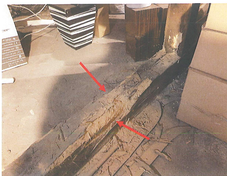
Fot. 27 Widok konstrukcji dachu pulpitowego przybudówki [degradacja biotyczna, znaczne zniszczenia tramu]
