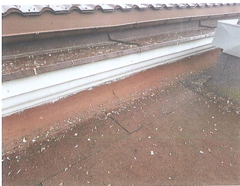
Fot. 6 Widok ofasowania okapu dachu głównego, wyciągnięcie pod gzyms pokrycia z papy zadaszenia nad zachodnią klatką schodową
