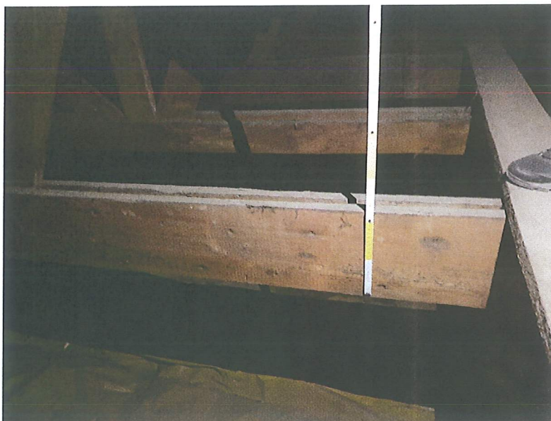
Fot. 13 Widok konstrukcji dachu głównego - deskowy wiązar kratowy [pas dolny]
