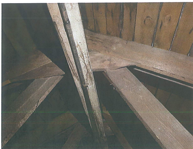
Fot. 12 Widok konstrukcji dachu głównego - deskowy wiązar kratowy
