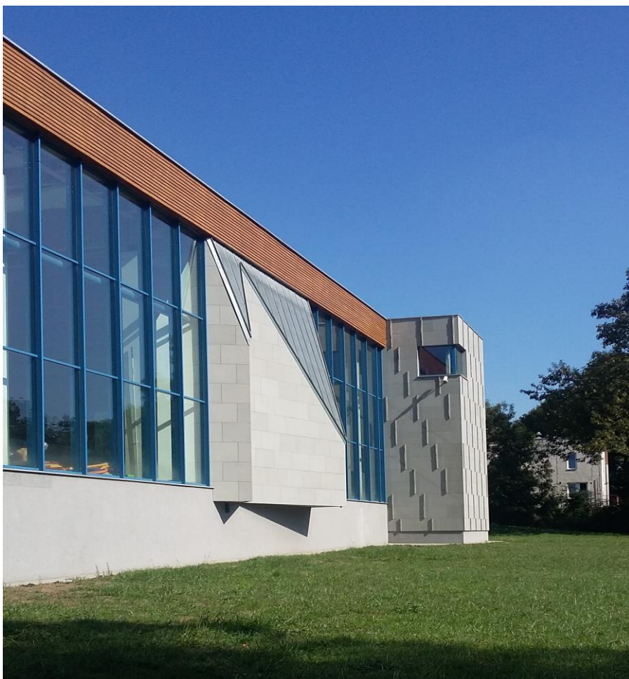
Zdj. 4 Elewacja południowa- widok
