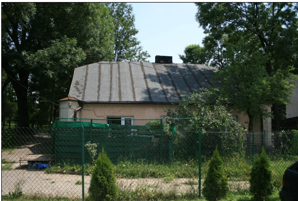
Fot. Elewacja tylna istniejącego budynku mieszkalnego
