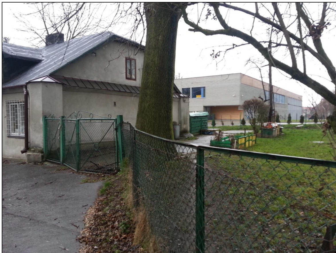
Fot. Elewacja boczna istniejącego budynku mieszkalnego
